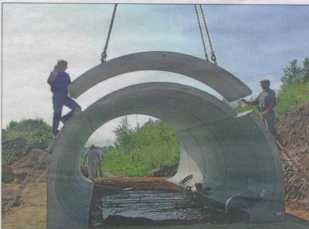
Der lægges lag på en buetunnel.
