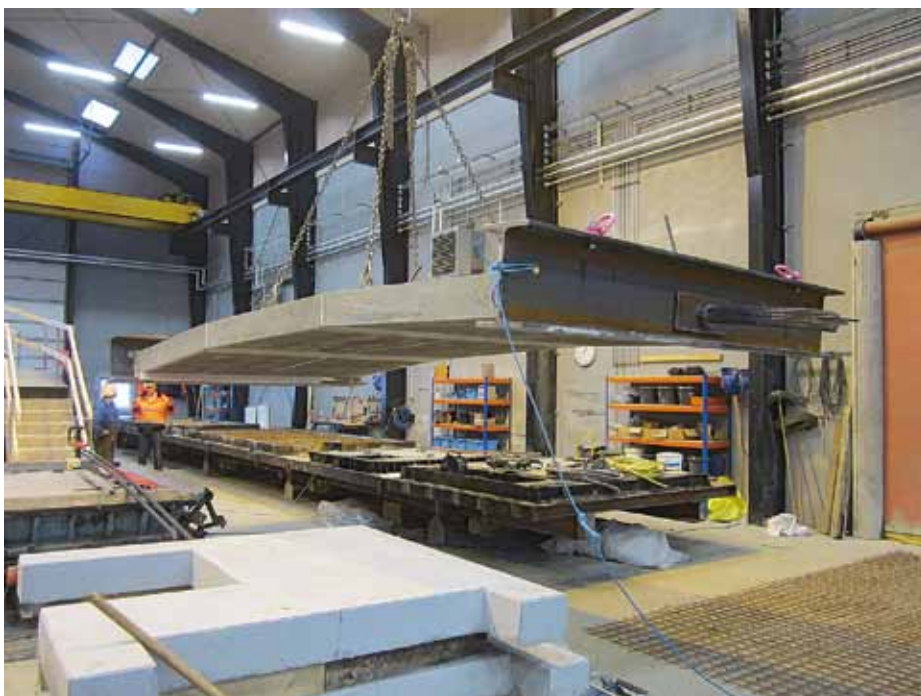
Figur 1. Betonbuen til testbro I løftes op på vederlaget. Testbroen består af 3 forspændte betonelementer.
